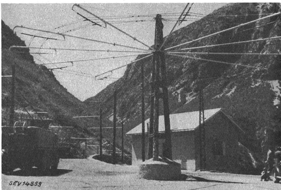
Fig. 16 Güter-Trolleybus im Oberveltlin Talwärts fahrender Güter Trolleybus mit leeren Transportkäfigen für Verkleidungssteine
