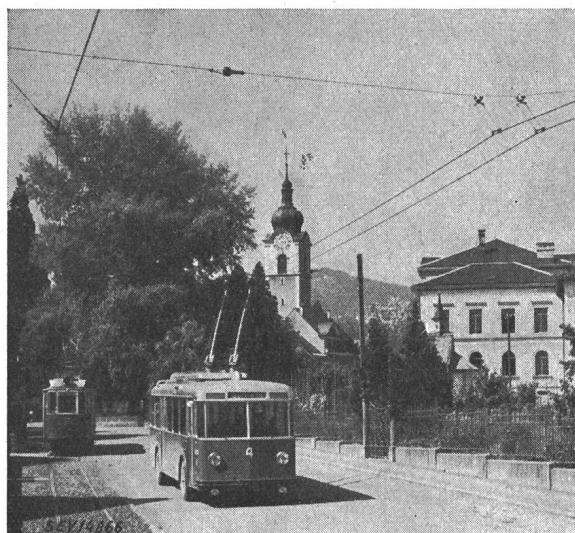
Fig. 1 Ueberland-Trolleybus der Rheintalischen Strassenbahnen (Rh. St.) Parallelstrecke Tram-Trolleybus in Altstätten (SG)
