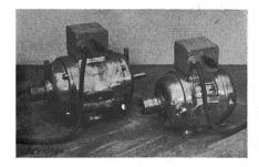
laire monté sur le moteur. Six extrémités de l'enroulement en cuivre, ainsi que le cordon de raccordement  $(3\,\mathrm{P}+\mathrm{T})$ , sont reliés aux bornes de l'interrupteur.
