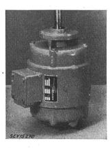
Moteur triphasé à induit en court-circuit, ventilé, protégé contre les projections d'eau, selon figure. Carcasse en métal léger venu de fonderie. Enroulement en fil de cuivre émaillé, avec imprégnation spéciale pour utilisation du moteur dans des locaux mouillés. Bornes de raccordement pour couplage étoile ou triangle, logées dans un boîtier vissé, prévu pour raccordement sous tubes isolants. Borne de mise à la terre. Moteur destiné à la commande de machines à laver.
