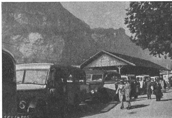
Die Wagenkolonne vor dem Bahnhof Meiringen
