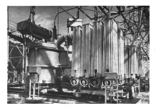
Die Uebertemperatur des Eisenkerns gegenüber dem ihn umgebenden Oel beträgt zirka 20 °C, gemäss Umrechnung des Resultates einer Spezialmessung an einem gleichartigen Eisenkern.
