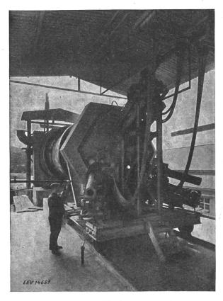
Fig. 1 Ofenkopf mit Elektroden des semi-industriellen Versuchsofens von 1000 kW zur Herstellung von Portlandzement-klinker mit Hilfe elektrischer Energie
