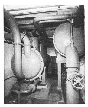
Fig. 14. Verdampfer (links) und Kondensator (rechts) der Wärmepumpenanlage
