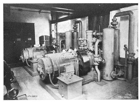
Fig. 13. Kompressorengruppen der Wärmepumpenanlage
