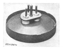
Description: Plaques de cuisson en fonte, de 180 resp. 220 mm de diamètre, selon figure, pour fixation sur des cuisinières normales.
