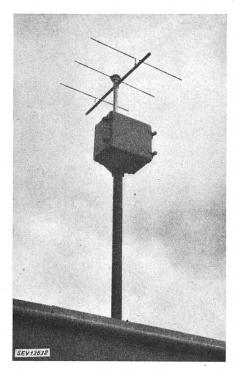
Fig. 12. Richtstrahl-Antenne vereinfachte Ausführung
