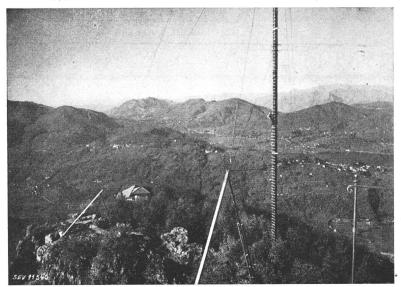
ment la cause des incendies provoqués par la foudre. On a tenté d'enregistrer à l'aide de l'oscillographe à boucles la valeur de crête et la charge du choc de courant de foudre. On y est parvenu en chargeant des condensateurs par des valves à cathode incandescente, d'une part avec la chure de potentiel au abunt du courant de foudre et d'autre
