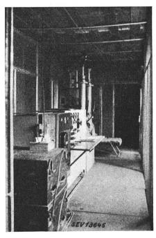
Fig. 7. Intérieur de la cage de Faraday, en 1945 avec deux oscillographes cathodiques à l'arrière-plan
