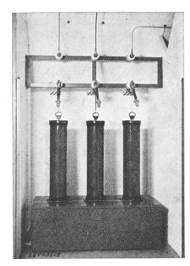
Fig. 6. Cellule de couplage pour 16 000 volts.
