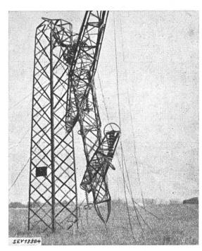
Fig. 1. Geknickter Eisenmast einer 150-kV-Leitung in Holland
