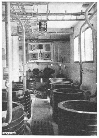
Serpentins en porcelaine A l'arrière-plan: Groupe convertisseur isolé pour le chauffage de l'amplificateur modulé Fig. 8.
