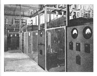
Fig. 7. Groupes mutateurs 18 kV, 400 kW
