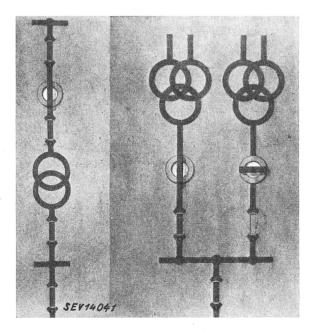
Fig. 2 Appareils pneumatiques de signalisation montés dans des tableaux de commande
