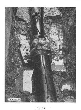
Permanente Meßstelle zur dauernden Kontrolle der elektrisch überbrückten Schraubmuffen-Verbindung an im Betrieb stehenden Wasserleitungen Die Enden der beidseitig der Muffe an die Rohrleitung angelöteten Messdrähte sind in Guss-Strassenkappen hinaufgeführt und damit jederzeit zugänglich. Die hartgelöteten Kontaktstellen sind mit Teer abgedichtet
