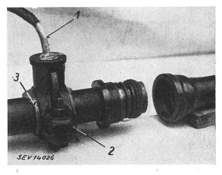
Fig. 4 Anschluss des Erdleitungskabels an die Wasserleitung und Schraubmuffe mit Stromüberbrücker
