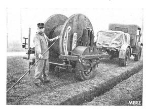
Fig. 2. Kabelwagen beim Verlegen direkt ab dem Wagen
