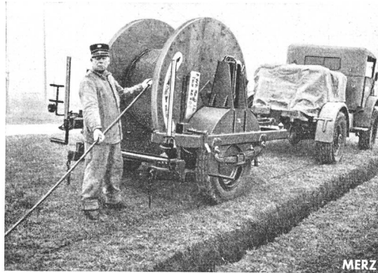
Fig. 2. Kabelwagen beim Verlegen direkt ab dem Wagen
