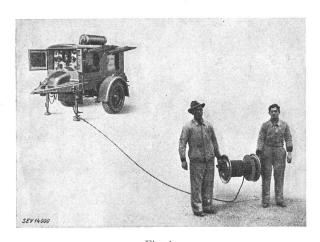
Fig. 4. Abrollen eines Kabels ab einer tragbaren Trommel
