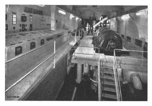
Fig. 9. Dampfturbinenkraftwerk Bern in Felskaverne mit Veloxkessel im Hintergrund (Brown Boveri)
