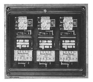
Fig. 7. Das 3polige Prozent-Differentialrelais TG ist der ganze Apparatebedarf des einschaltsicheren Prozentschutzes für Transformatoren
