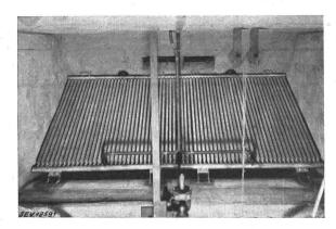
Fig. 3. Verdampferelement im Abluftschacht
