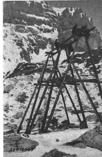
Fig. 9. Bockmast in Montage
