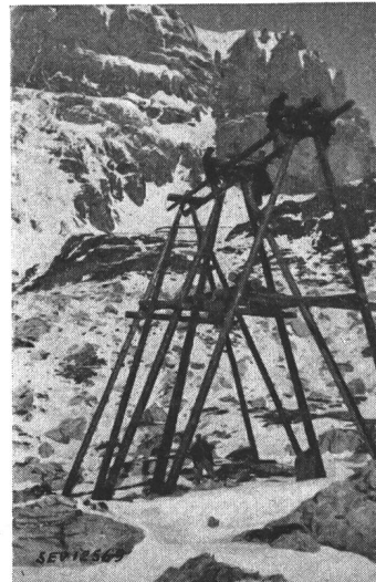
Fig. 9. Bockmast in Montage
