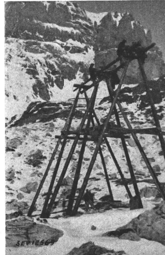
Fig. 9. Bockmast in Montage
