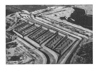
Fig. 28. Imperial Dam mit Absetzbecken für den All American Canal
