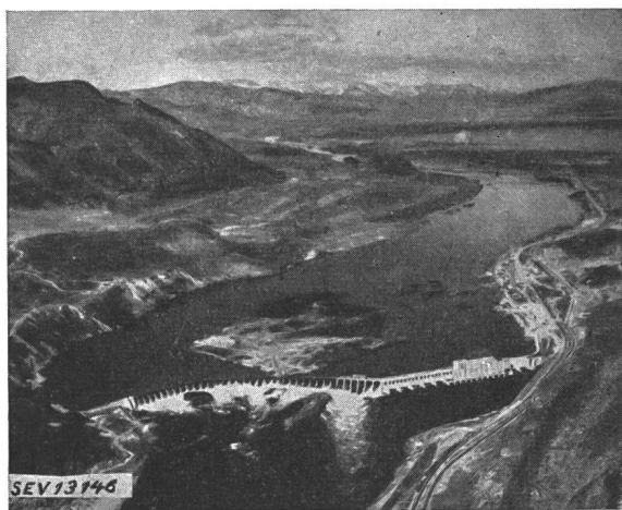
Fig. 9. Rock-Island-Kraftwerk [4 (später 10) × 16 667 kVA]
