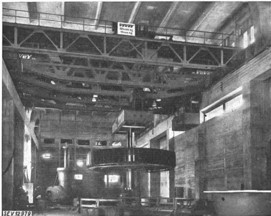
Fig. 1. Kraftwerk Rapperswil-Auenstein Maschinenhaus mit 2 Laufkränen von 125 t Tragkraft
