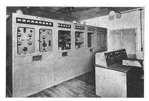
Fig. 11. 10-kW-Mittelwellensender Typ SO 26/10k betriebsfertig montiert
