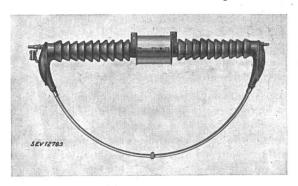
Fig. 1. Schleifenwandler, 150 kV, für Freiluftaufstellung (gebaut 1920...1930)
