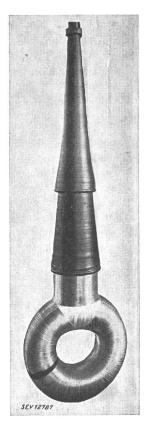
eingeschlossen. Das ganze Gebilde gleicht einer Ringöse mit Stiel. Auf die Metallverschalung wird die Papierisolation in Streifenform, ähnlich wie bei der Kabelfabrikation, in der nötigen Dicke aufgewickelt.
