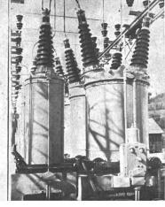
luftisolierten Rückleitung bestanden. Fig. 1 zeigt einen solchen Wandler, der noch 1930 von Sprecher & Schuh ausgeführt wurde. Verschiedene Nachteile — die grosse Windungslänge der Primärwicklung und damit im Zusammenhang deren grosse Empfindlichkeit gegen steile Wanderwellen, der umständliche Einbau in Freiluftanlagen sowie nicht zuletzt der hohe Preis — verhinderten auch hier eine weitergehende Verwendung in Anlagen höherer Spannung.
