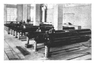
Fig. 7. Schweissen von Betonarmierungseisen
