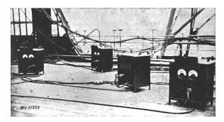
Fig. 5. Schweißstromregler auf Deck eines Schiffes
