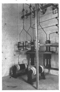
Fig. 7. **Trocken-Messwandlerzelle**für 16 kV Nennspannung, 64 kV Prüfspannung
