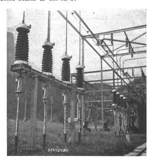
Fig. 6. Kabelendverschluss-Wandler 150 kV Nennspannung
