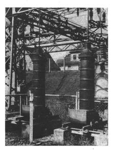
Fig. 12. Oelarme Säulenspannungswandler 16% Hz, 66 kV Nennspannung
