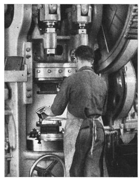
Fig. 2. Ziehvorgang eines Gehäuseoberteils aus Aluminium
