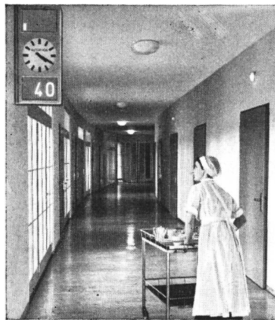
Fig. 2. Lichtruf- und Personensuchanlage in einem Kranken- haus
