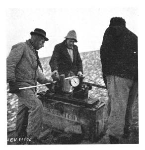
Fig. 39. Pressen einer Stahlmuffe zur Verbindung der Stahlseele
