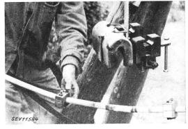
Fig. 7. Soudure terminée sur le poteau dispositif de refoulement enlevé
