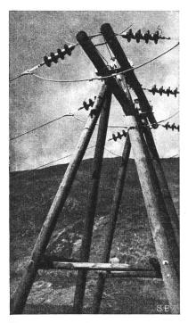
Fig. 1. Soudures «Alutherm» dans les boucles de la ligne 65 kV Mörel-Tourtemagne (Valais) Corde en aluminium pur de 300 mm<sup>2</sup>
