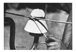
Fig. 9. Confection d'une attache croisée renforcée Les deux brins du fil de ligature ont déjà entouré une fois la gorge de l'isolateur. A l'endroit du croisement, les deux brins demeurent parallèles!
