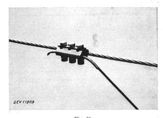
Fig. 30. Serre-fils de dérivation Cu-Al protégé contre la corrosion avec tube en aluminium enfilé sur le conducteur en cuivre et dont l'extrémité libre est aplatie et coudée, afin d'empêcher toute pénétration d'eau. Serre-fils en alliage d'aluminium avec rondelles élastiques bombées en acier galvanisé. L'eau ne peut s'écouler qu'en direction Al-Cu. Les rondelles sont placées sous la tête des boulons!
