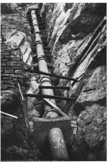
Fig. 4. Steile Strecke der 500-mm-Druckleitung der Pumpanlage Tsi
