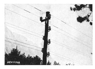
Fig. 27. Joints torsadés d'une ligne de télécommunication, dont les fils ont été croisés ultérieurement
