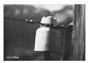
Fig. 7. Attache croisée simple (pour conducteurs massifs minces) sans ruban
