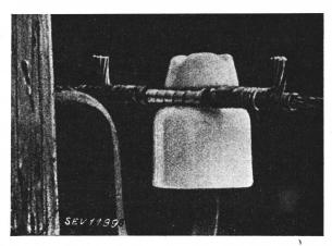
Fig. 16. Beugli constitué par un tronçon de câble Vue de l'arrière.
