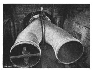
Fig. 3. Etzelwerk Geschweisstes Hosenrohr mit Kragenverstärkung.
