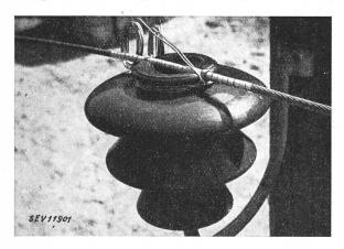
Fig. 19. Confection d'une attache sur la tête d'un isolateur prévu spécialement dans ce but
