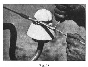
Attache croisée renforcée Terminaison•d'une des spirales de la ligature. Cette attache a été confectionnée sans l'aide d'un outil!
