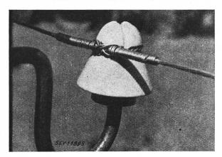
Fig. 13. Attache croisée avec deux fils de ligature
