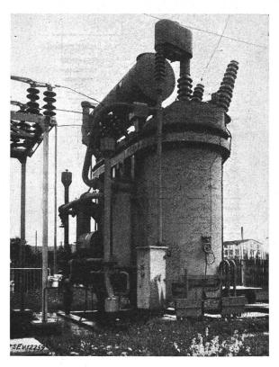
Fig. 1. 35-MVA-Transformator 150/50 kV
