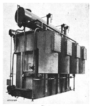
Fig. 5. 47 500-kVA-Transformator mit 150-kV-Kabelanschlüssen
