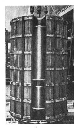
Fig. 15. Eisenkern eines grossen Lokomotivtransformators für 2700 kVA, 16<sup>2</sup>/<sub>3</sub>Hz Radialgeblechter Kern mit quergeblechtem Zwischenjoch, für eine Wicklungsanerdnung mit oberspannungsseitiger
