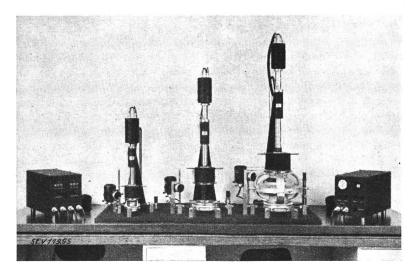
gedreht, bis die charakteristische Figur, wenn die Spannungen in Phase sind, auf dem Schirm der Kathodenstrahlröhre entsteht. Den Winkel zum Schwerpunkt des Kreisels erhält man direkt auf der gradierten Teilung, und die Grösse der Unwucht erhält man durch Abmessung der totalen vertikalen Ablenkung des Kathodenstrahls. Diese Werte gelten für die eine Seite, und entsprechende Messungen müssen deshalb für die andere Seite des Kreisels vorgenommen werden, was dadurch ge-
