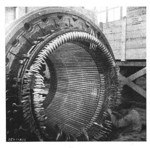
Fig. 18. Aluminiumstatorwicklung; Hartlöten der Spulenverbindungen (Brown Boveri)
