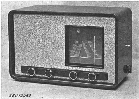
**Description:** Appareil combiné de radiophonie et de télédiffusion selon figure, pour la réception d'ondes longues, moyennes et courtes ainsi que pour la télédiffusion à basse fréquence et l'amplification gramophonique. Régulateur de puissance, régulateur de tonalité, régulateur de largeur de bande et sélecteur de programme. Prise pour un second haut-parleur.
