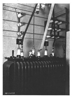
Fig. 1. L'ampèremètre monté directement sur les bornes haute tension d'un transformateur
