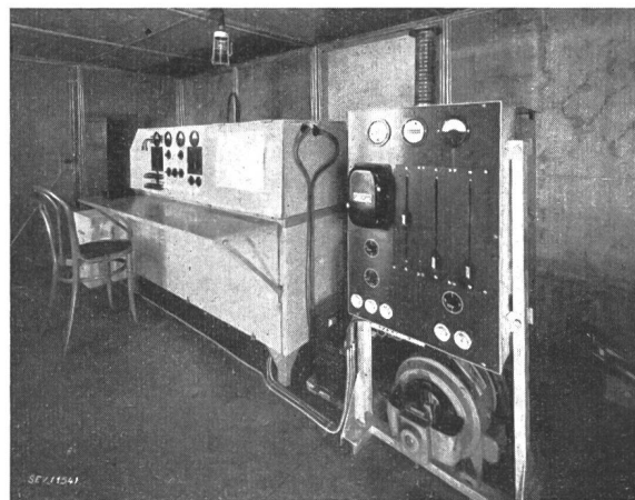
Fig. 3. Inneres des Faraday-Messkäfigs Batterie im Hintergrund, Umformer mit Regler im Vordergrund, Spezial-Registrieroszillograph in der Mitte (geschlossen, messbereit)
