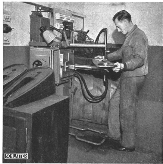
Fig. 18. Anpunkten von Bestandteilen an Kettenschutzkästen für Fahrräder
