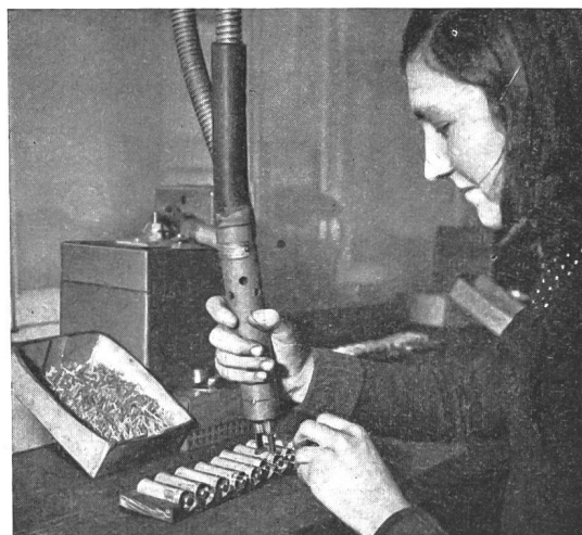
Fig. 25. Schweissen mit Kohlestift von Taschenlampenbatterien
