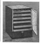
Description: Séchoir électrique selon figure, comprenant un bâti métallique, des parois en éternite émaillé et 6 tiroirs composés d'un cadre métallique et d'un fond en treillis. Le raccordement du cordon d'alimentation s'effectue par une fiche d'appareil.
