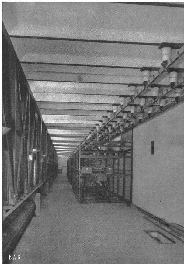
Fig. 18. 13-kV-Raum mit indirekter Beleuchtung
