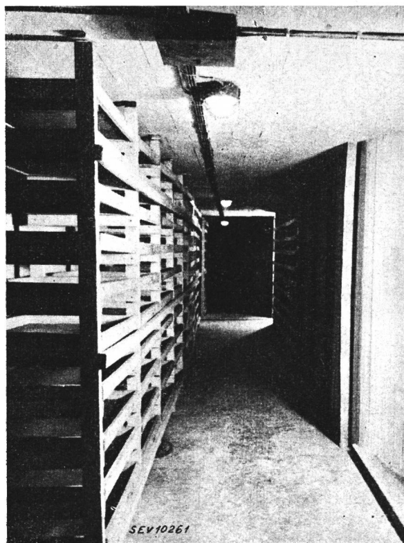
Fig. 1. Dörrhurden im Generatorabluftkanal.
