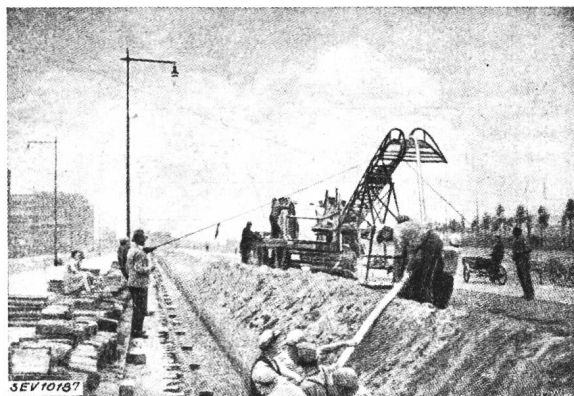
Fig. 8. Auslegung des 150-kV-Kabels Haag-Rotterdam. Erstellungsjahr 1939 (AEG, Berlin).
