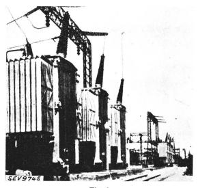
Fig. 6. 287/132-kV-Autotransformatoren.  $3\times80~000~\rm{kVA}$
