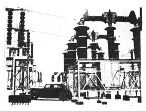
Fig. 4. Oelarmer Schalter (Gen. El.) für 287 kV.
