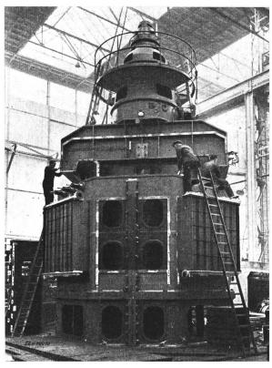
Fig. 1. Montage eines 52 250-kVA-Drehstromgenerators für die Kraftwerke Oberhasli A.-G. auf dem Prüfstand in der MFO.
