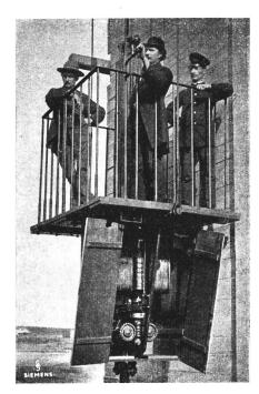
Fig. 8. Fahrstuhl von 1880 mit D-Maschine als Antrieb.
