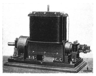
Fig. 4. Wassergekühlte Maschine mit Doppel-T-Anker (1868).
