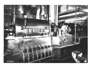
Fig. 12. Turbokompressorantrieb für Wärmepumpe
