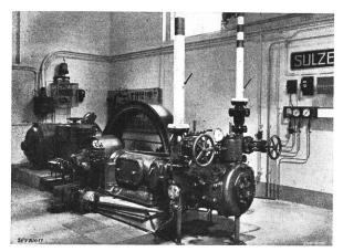
Fig. 11. Kolbenkompressorantriebe für Wärmepumpe
