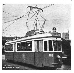
Fig. 5. Leichttriebwagen mit Simplex-Drehgestellen
